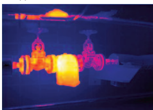
Проверка функциональности паропроводящих труб
